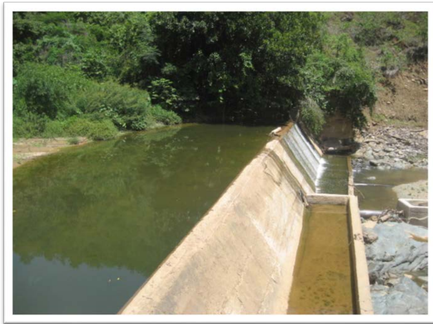
Figura 4.28. Obra de Derivación en el Sitio Río Guárico en Las Vegas
