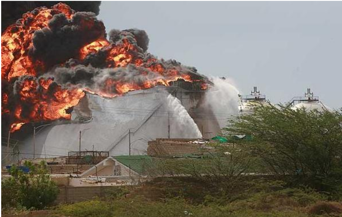
Fotografía i.3: Aplicación simultanea de agua y espuma redujo efectividad de la espuma para sofocar el incendio
