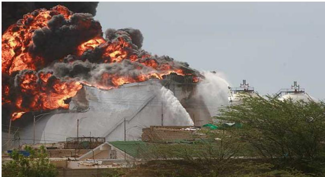
Práctica inadecuada arrojando agua y espuma al mismo punto
