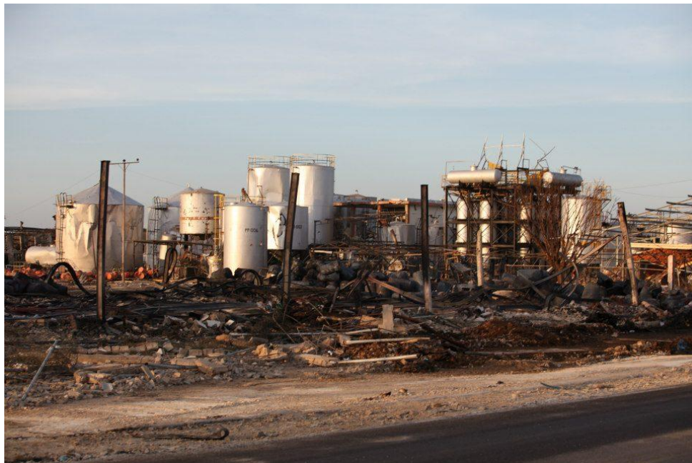
Foto 4.67: Vista de daños área producción y almacenaje planta PURAMIN. Fecha: 25-08-12
