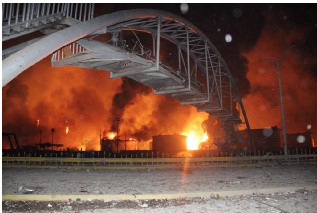
Foto 4.12: Incendio en los tanques del Bloque 23. Estructura de la pasarela peatonal parcialmente destruida por la explosión, donde falleció una persona.
