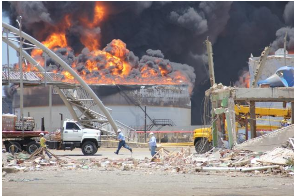
Foto 4.17: Primera hora del 25 de agosto, no se observan acciones de enfriamiento y mitigación del incendio en los tanques de crudo, se observa parte de la estructura del Restaurant Toripollo.
