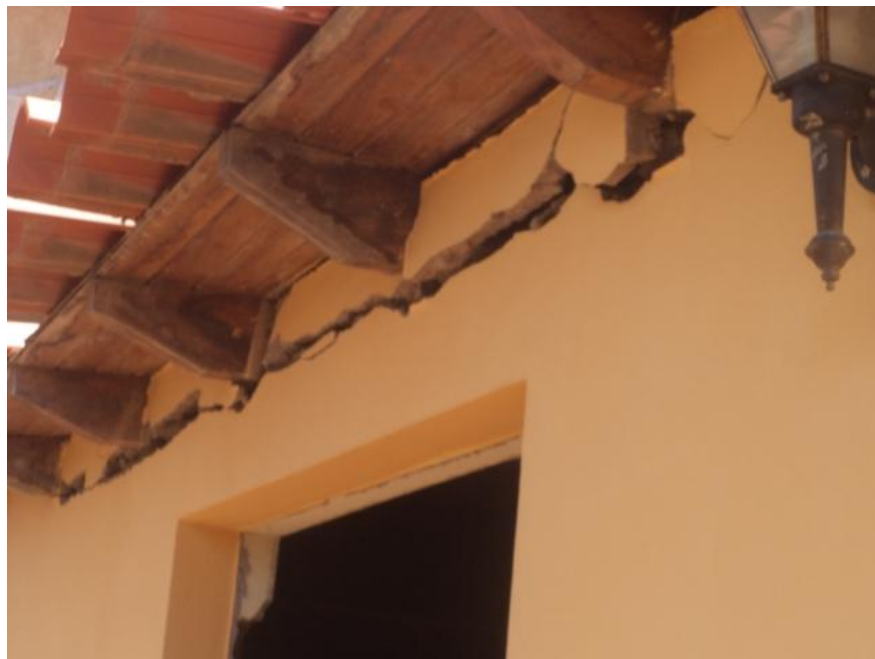
Foto 4.46: Colapso de la estructura de las viviendas, producto de la onda expansiva
