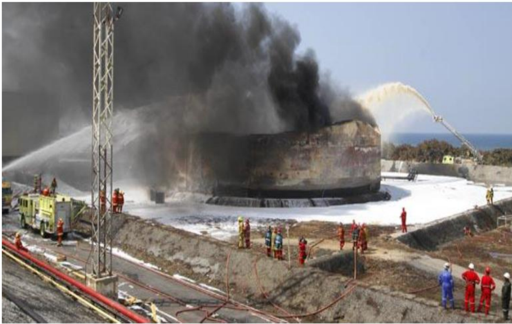
Incendio de tanque en Refinería El Palito, septiembre 2012. Se reitera práctica inadecuada de combate arrojando agua y espuma al mismo punto
