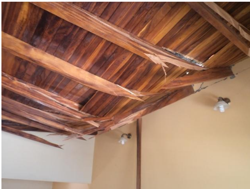
Foto 4.47: Colapso del techo y estructura de la vivienda de la Familia Cordero, Sector La Pastora
