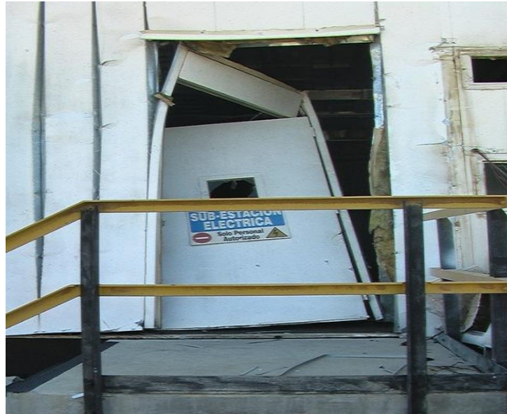
Foto 4.83: Vista de daños en la subestación eléctrica de CHP.
