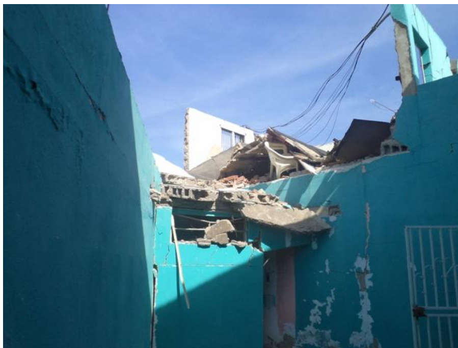
Foto 4.45: Colapso de la estructura de las viviendas, producto de la onda expansiva
