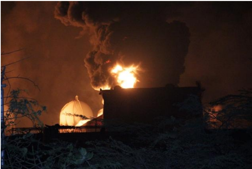
Foto 4.10: Propagación del incendio posterior a la explosión por acumulación de gas en los alrededores de los tanques del bloque 23
