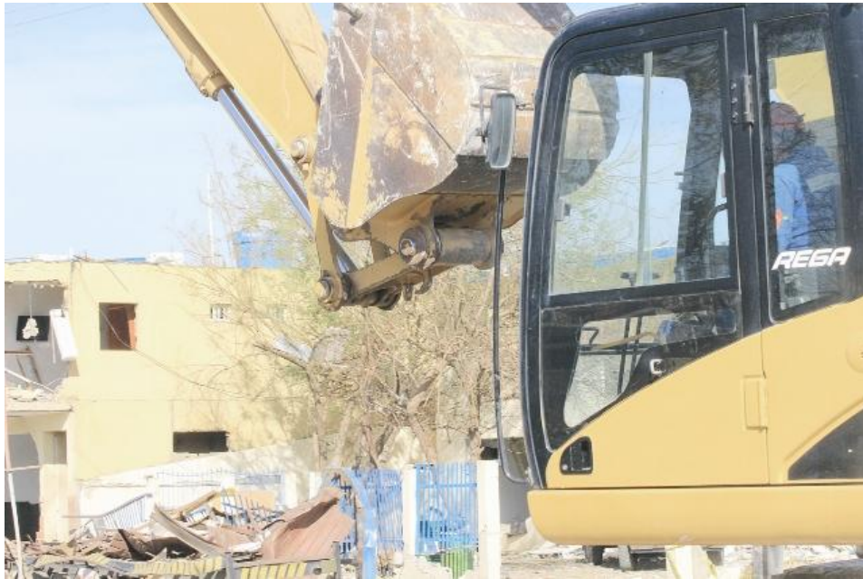
Foto 4.63: Remoción de escombros con maquinaria en zonas Comerciales. Método inapropiado ante posibles personas heridas y extraviadas, y violatorio de los procedimientos para la investigación
