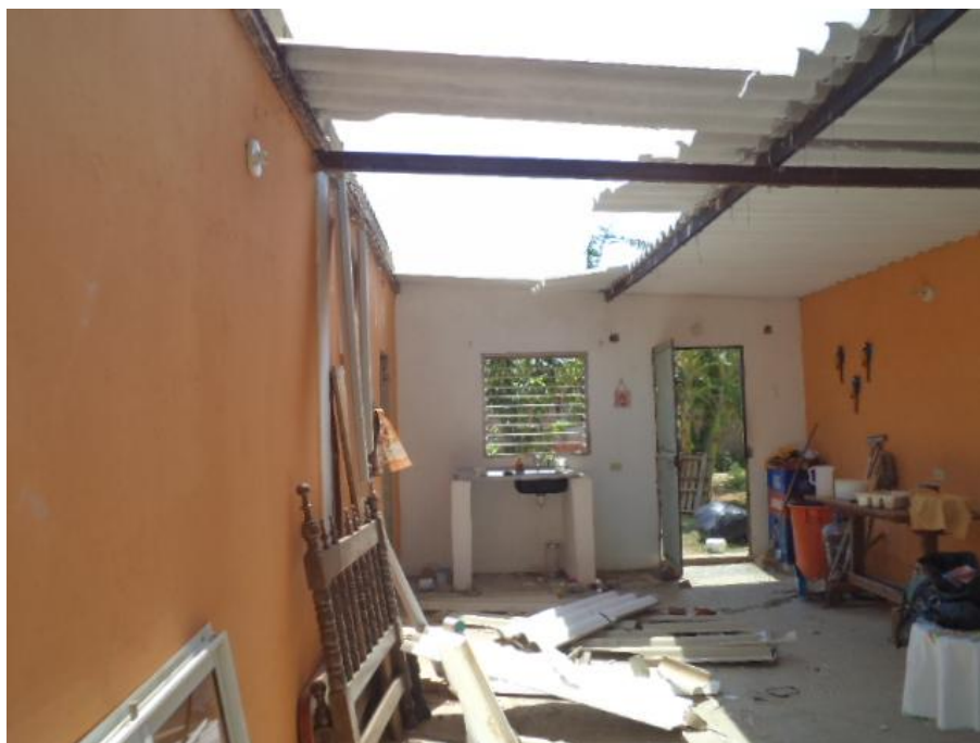
Foto 4.44: Daños en zonas residenciales extendidos a distancias superiores a los 3 km del foco del incendio, en este caso techos y parte de las estructuras
