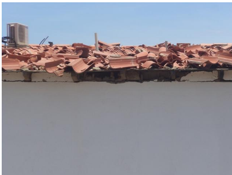
Foto 4.51: Vista externa del colapso de los techos de las viviendas afectada. Sector La Pastora
